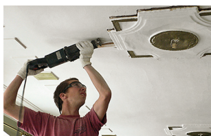
Tømrersvend Gert Rasmussen nedtager nænsomt de gamle stuk-dele fra loftet. Guldbemalingen på dele af stukken er en forholdsvis ny tilføjelse.
