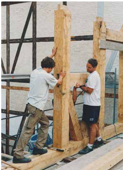
To tømrersvende under efteruddannelse i Den Gamle By lærer at restaurere renæssancebindingsværk.
